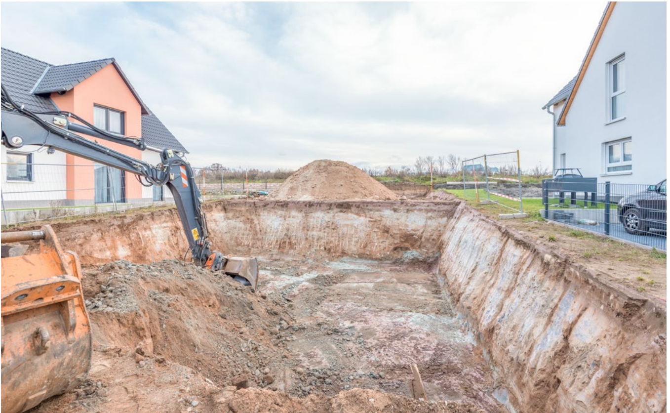
Aushub einer Baugrube für ein Einfamilienhaus
